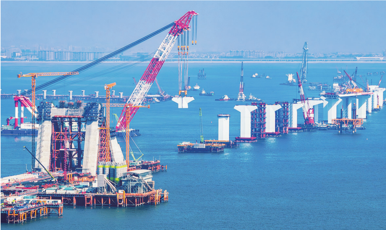
厦金大桥(厦门段)项目A1标段在进行沿线预制墩台吊装(2026年1月9日摄,无人机照片)。目前,厦金大桥(厦门段)项目跨海工程已从“立塔成型”转入“悬索成桥”关键施工阶段。厦金大桥(厦门段)项目于2023年10月动工,路线全长约19.6公里,其中主线长约17.34公里,翔安支线总长约2.27公里。新华社记者 魏培全 摄
