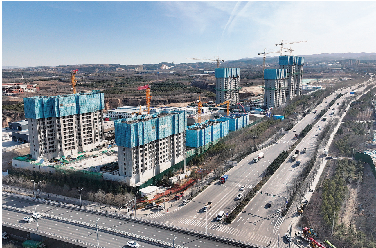
3月18日，杏花岭区柏杨树城中村改造项目正在施工中。该项目位于文子头街，共5栋高层住宅。目前，整体建设进度达50%。张昊宇 摄
