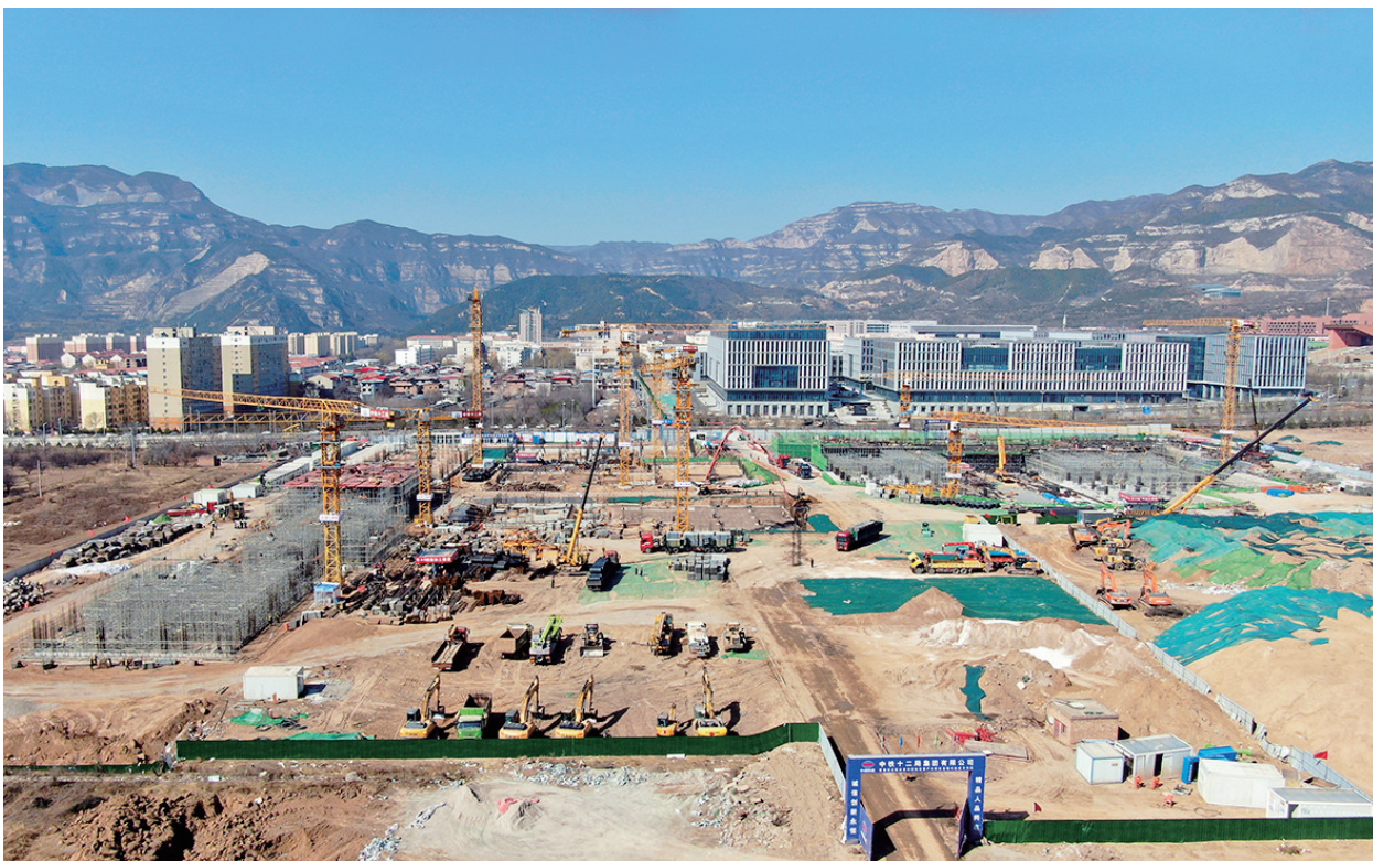
3月21日,位于中北高新区的“晋创谷·太原”未来和国际智慧产业园区,一派忙碌的建设景象。该园区由中铁十二局承建,总建筑面积近15万平方米,重点培育AI人工智能及高端智能制造产业集群。目前,项目桩基施工已全部完成,基础施工正在加紧推进。赵世凯 摄
