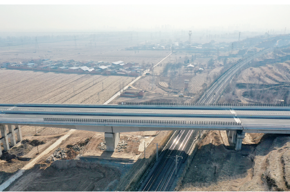
图为国道108线忻州段改建工程的关键桥梁小泉沟特大桥。
