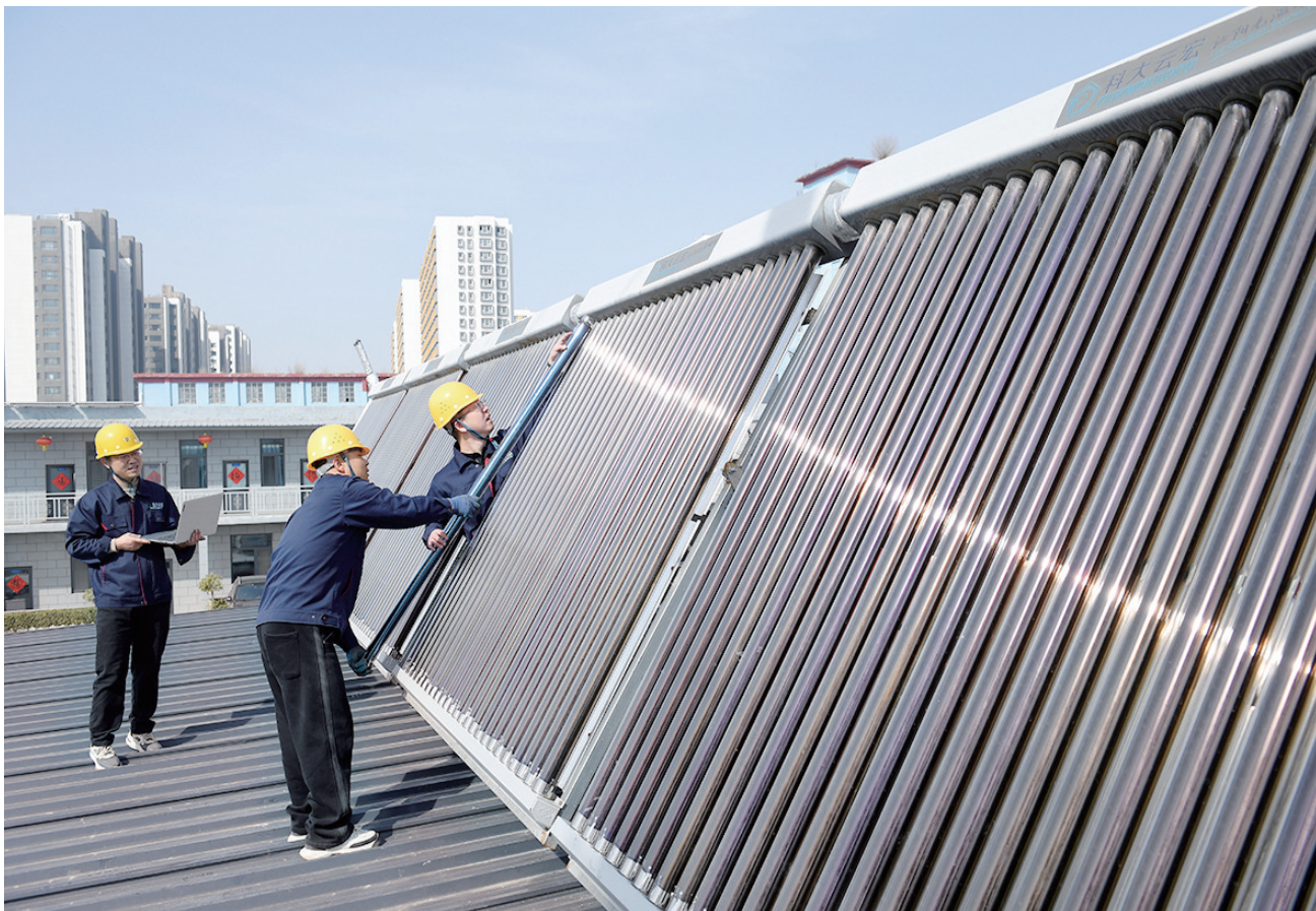
3月25日，山西科大云宏科技有限公司产品展示区内，工作人员在安装调试大口径串联“玻璃—金属”管式太阳能集热器。该公司坚持自主研发，深耕太阳能集热、光伏发电、空气源热泵等领域，系统集成技术和产品已处于国际领先水平。牛利敏 摄
