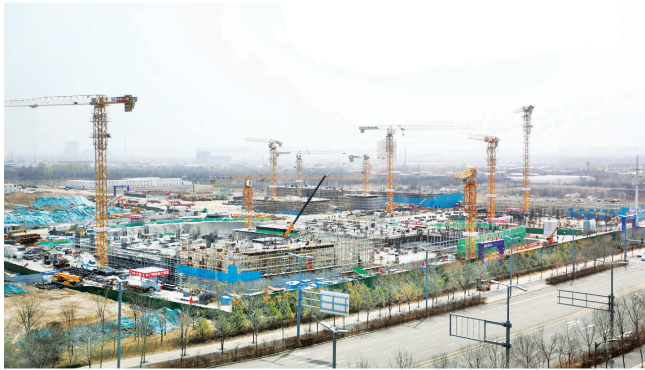
3月26日,“晋创谷·太原”科技和产业创新融合区建设项目现场一派繁忙。该项目位于尖草坪区中北大街,是“晋创谷·太原”未来和国际智慧产业园区基础设施建设项目中的一部分。目前已完成桩基、工程桩桩检。A区域5栋单体转入地上工程施工。
