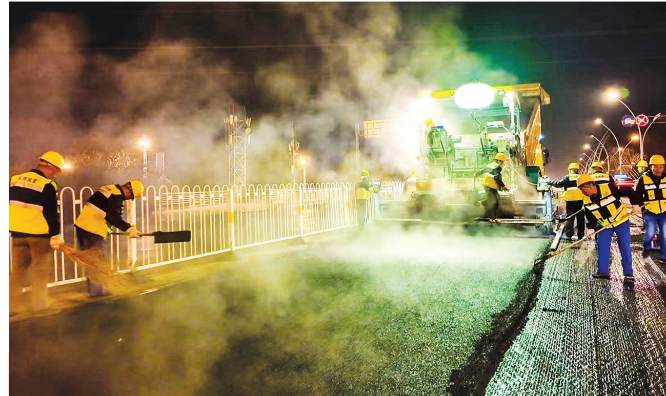
3月26日7时许,市市政建管中心市政道排保障二所圆满完成南内环桥东向西方向路段维修养护工作。牛利敏 杨斌 摄影报道
