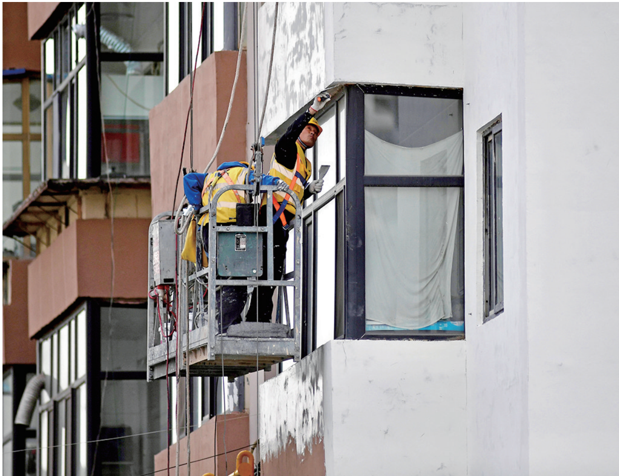
3月28日,施工人员在尖草坪区北宫小区外墙进行粉刷,昔日斑驳的墙面焕然一新。为进一步提升城市面貌,尖草坪区政府稳步推进老旧小区改造和城市危旧房改造,同时实施城市老旧管线升级,重点推进供水、供暖、供气及雨污管网的改造工作。 邓寅明 摄
