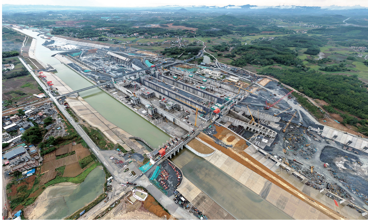
这是3月29日拍摄的平陆运河金石枢纽建设现场（无人机照片）。
