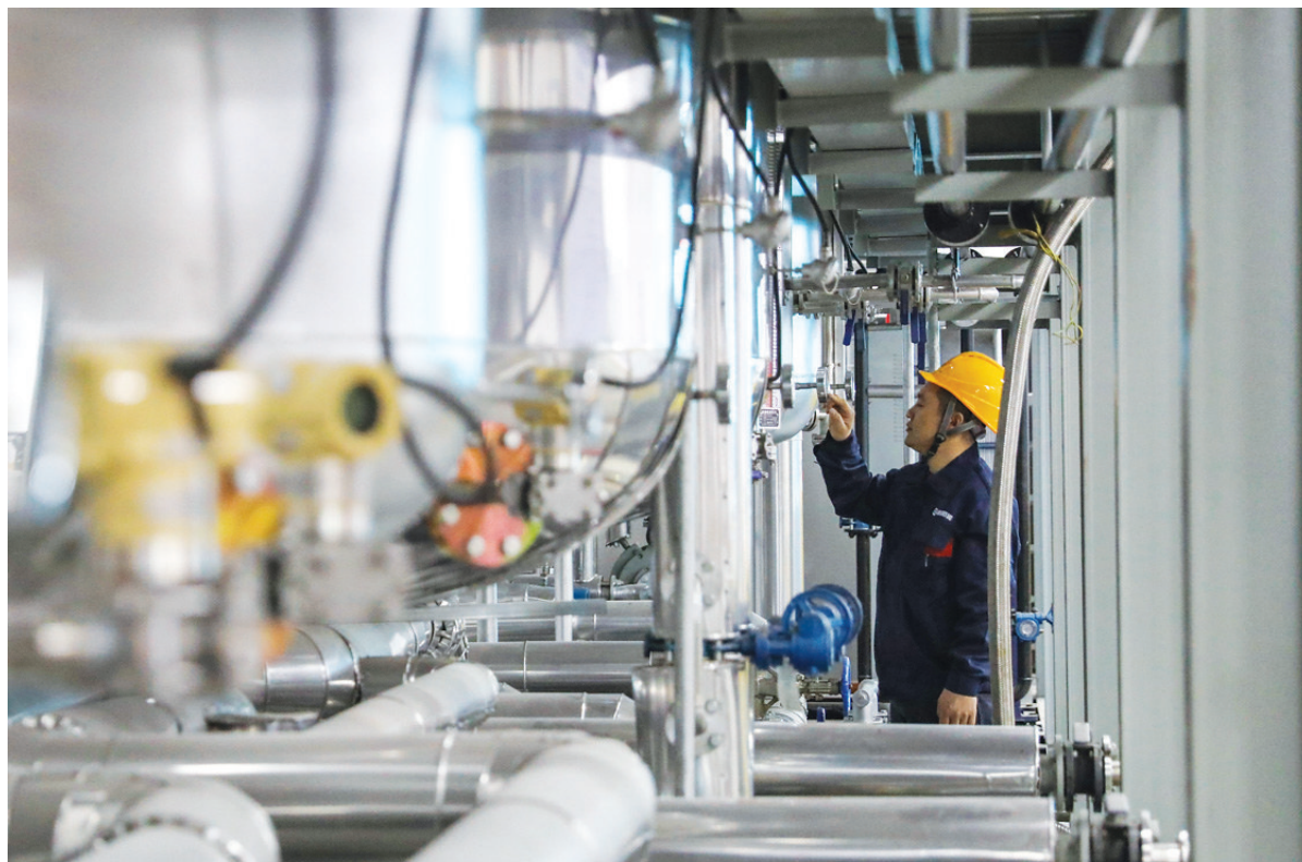
3月30日，山西峰和低碳材料科技开发有限公司零碳智慧工厂内，工作人员对生产设备进行日常巡检。该公司始终将安全生产置于首位，通过常态化隐患排查、标准化操作流程和精细化设备管控，筑牢安全生产防线。郭苑甫 摄
