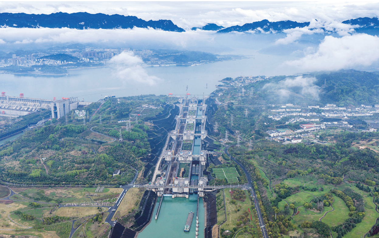
3月30日，湖北宜昌，三峡枢纽南线船闸正加紧检修，北线船闸有序通航（无人机照片）。三峡南线船闸2026年计划性停航检修于3月4日开工，计划工期45天，目前施工进度过半。检修期间，三峡枢纽通航保障有力，各类重点急运物资有序过坝。新华社发（郑家裕 摄）
