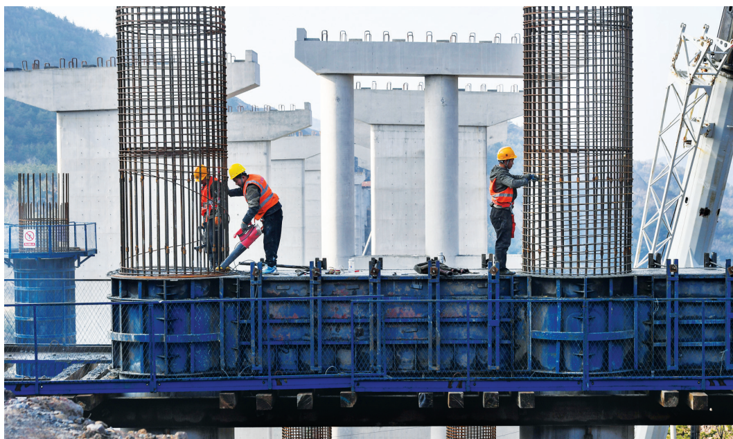
3月31日,青银二广高速公路太原联络线项目迎泽区董家庄附近,施工人员进行高架桥墩的作业。目前,该项目东山2号隧道左、右双洞顺利贯通,东山3号隧道正在快速推进中。项目建成后将成为太原通往阳泉、石家庄更为便捷的通道。牛利敏 摄
