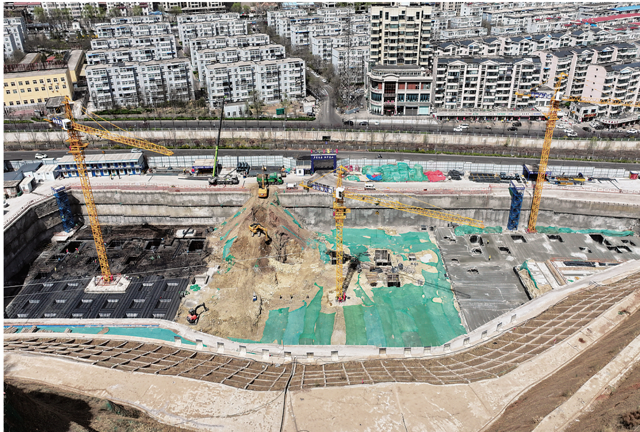
4月5日,新建白家庄回迁安置房城中村改造工程项目正稳步推进,进入地基基础施工阶段。该项目总建筑面积9万余平方米,建成后 will 改善白家庄村民居住状况。 张昊宇 摄
