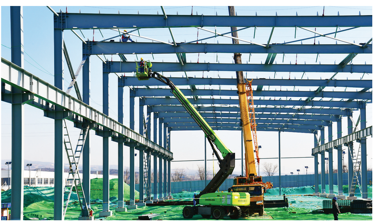
4月5日，位于中北高新区的高端金属材料加工生产基地项目，正在进行钢结构施工。该项目由山西常达精密金属科技公司投资建设，总建筑面积1.8万平方米，投产后将满足我市及周边企业对薄金属带材深加工的需求。 赵世凯 摄
