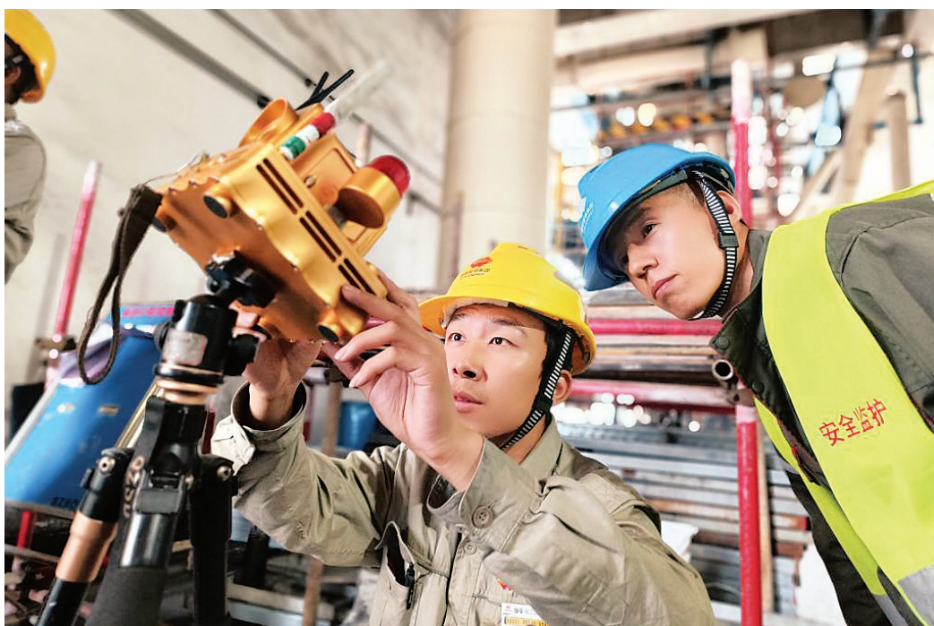
国能宁夏煤业气化二厂的工程师在进行气化装置检修(2025年9月摄)。(陈亚楠 摄)
