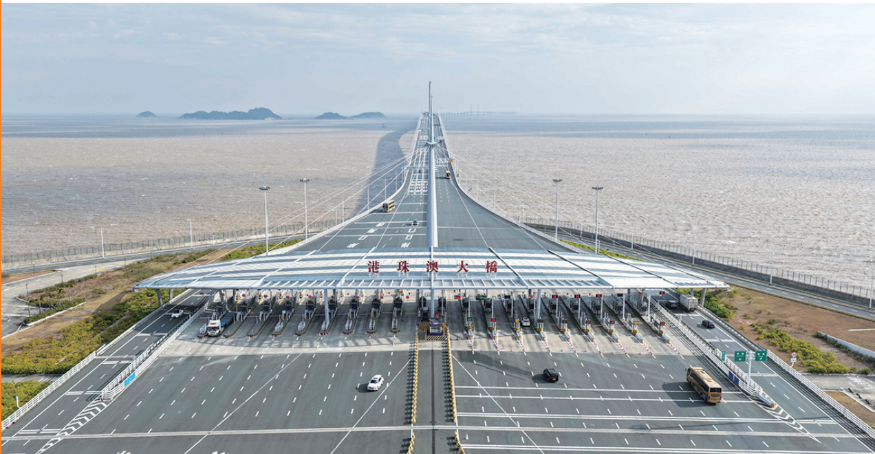
这是2026年1月6日拍摄的港珠澳大桥出入口(无人机照片)。
