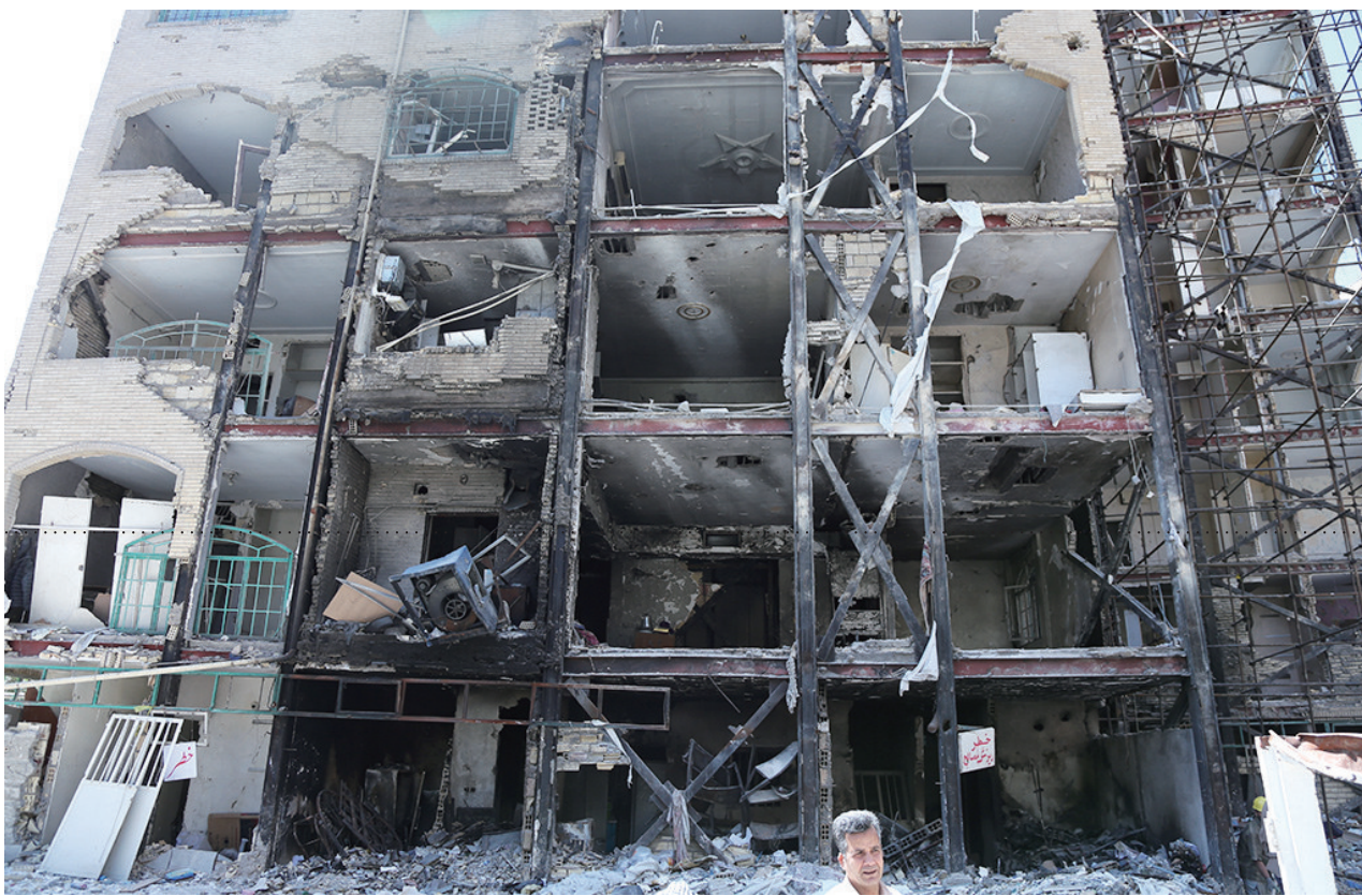
这是4月14日在伊朗首都德黑兰东南部一处居民区拍摄的遭美以袭击严重受损的楼房。美以袭击给居民区造成人员伤亡和严重财产损失,当地居民强烈谴责。 新华社记者 沙达提 摄
