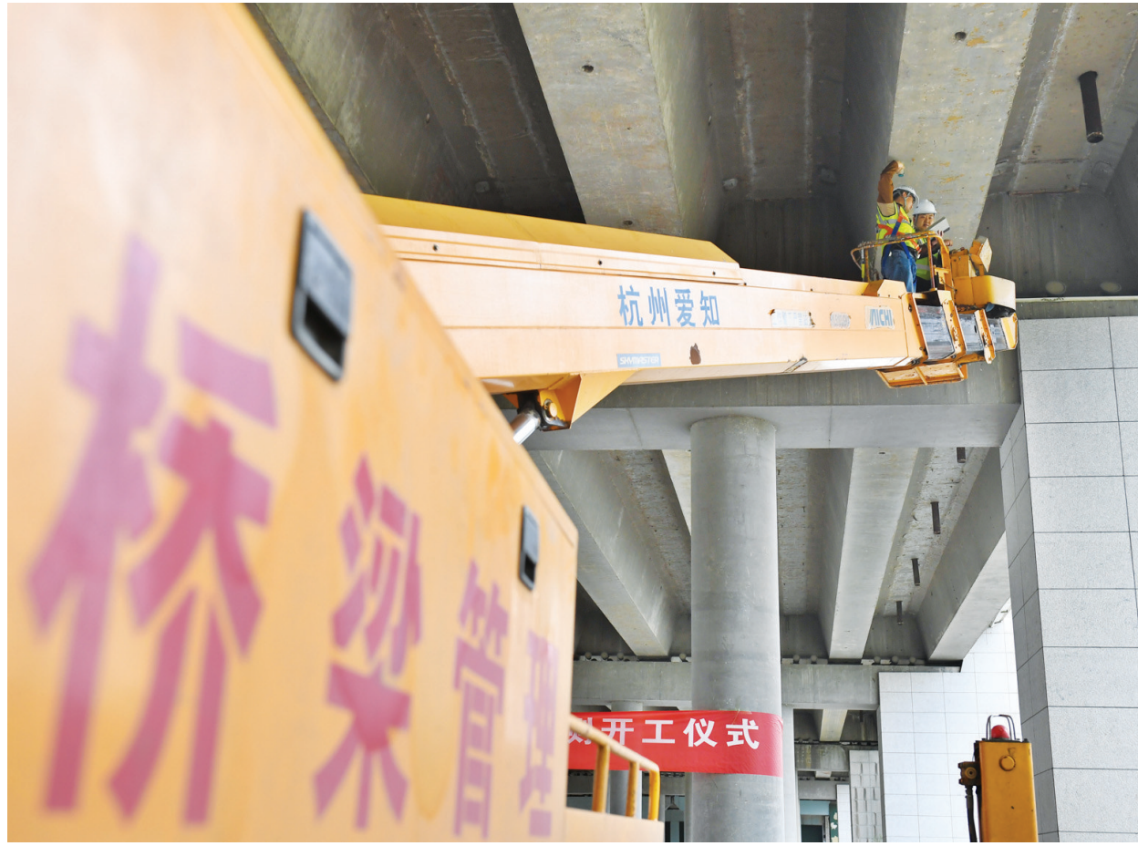
4月16日,太原市政建管中心全面启动2026年度城市桥梁安全排查检测工作,将对柴村桥、振乐桥、北中环桥等21座桥梁进行检测,出具检测报告,并组织专家评审,为桥梁管养工作提供科学依据。
