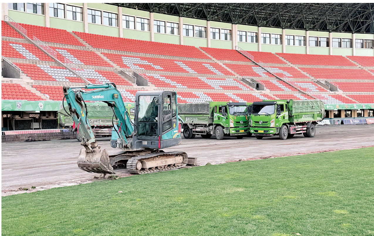
为保障市民健身安全、提升运动体验,4月17日,华航体育场馆管理(山西)有限公司开始对山西体育场跑道路面进行全面更新改造,工期约一个月。该跑道已投入使用超30年,目前出现起泡、脱胶、老化等问题,存在安全隐患。王韵菲 摄
