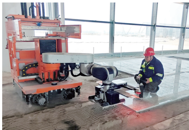
图为石材铺贴机器人“上岗”施工。
