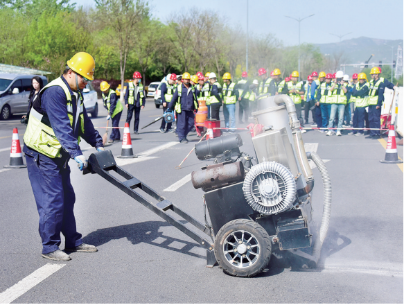
4月17日，太原市市政建管中心组织开展道路灌缝技术观摩活动，通过实景实操、对标学习、现场交流的方式，着力破解作业不规范、细节把控不到位等问题，进一步提升市政道路养护作业质量与水平。 牛利敏 杨斌 摄影报道
