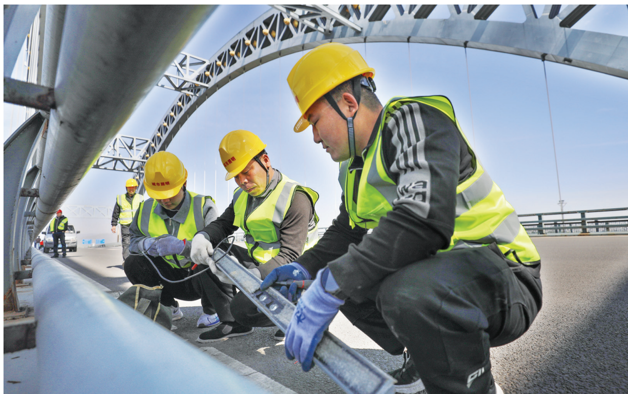
4月28日,市城管照明部门启动对晋阳桥景观亮化设施巡查巡查工作。为全力保障“五一”期间全市跨河桥梁亮化稳定运行,该部门近日开展巡查巡查,目前已顺利完成漪汾桥、迎泽桥等12座桥梁的相关工作。郭苑甫 摄
