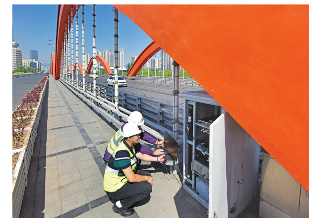
5月1日，工作人员在漪汾桥上调试智能感知设备。 牛利敏 杨斌 摄影报道
