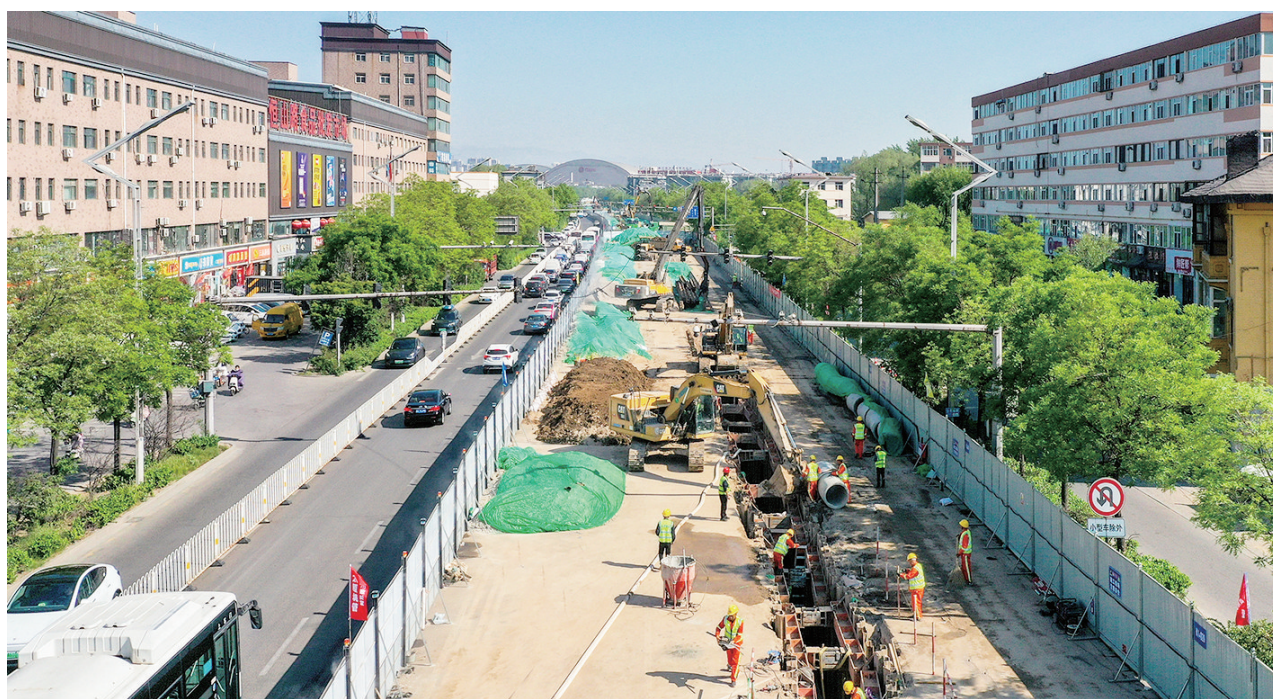
5月1日，恒山路雨污分流改造工程施工现场一派繁忙。施工人员坚守建设一线，抢抓工期，有序作业。 牛利敏 摄
