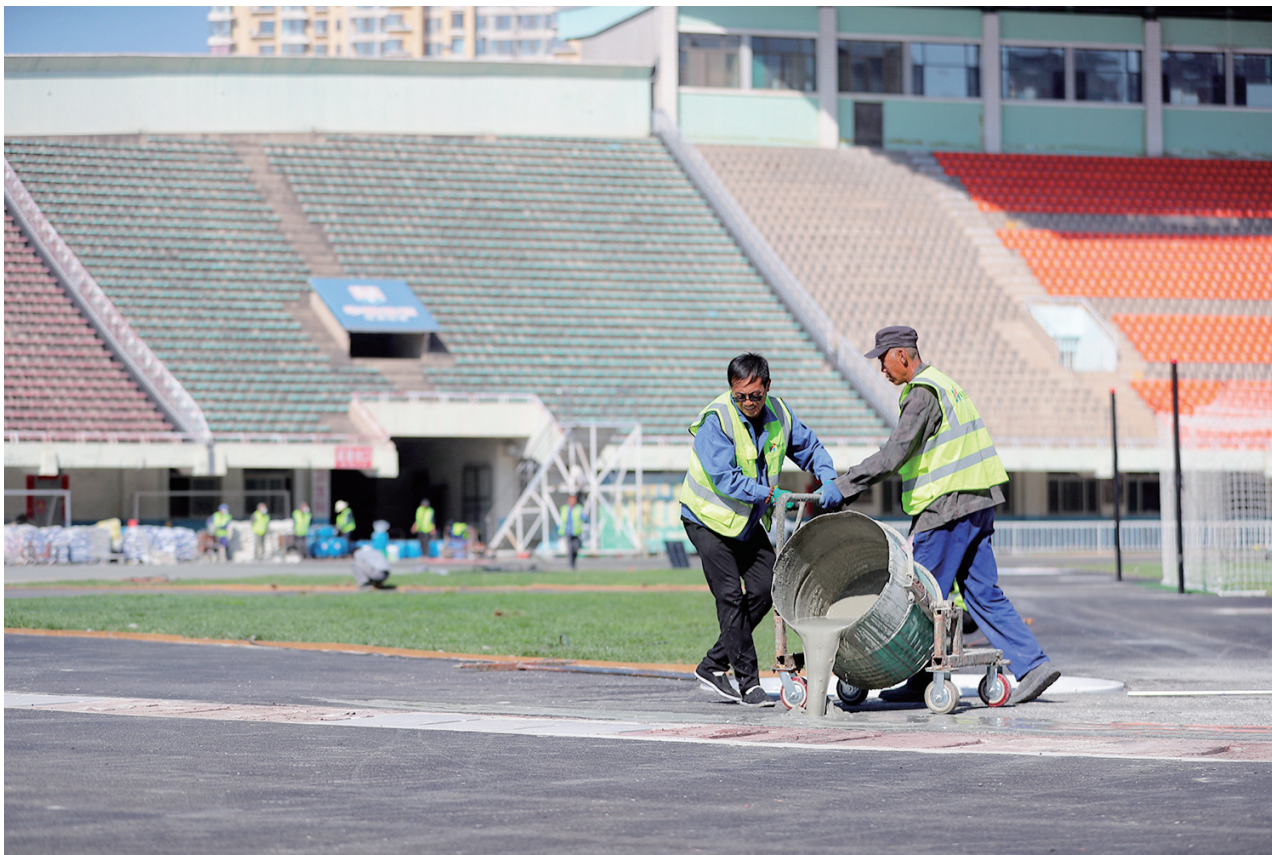
5月4日，山西体育场跑道路面更新改造项目现场，工作人员坚守岗位，正全力开展沥青铺设准备工作。他们用辛勤劳动致敬“五一”国际劳动节，成为节日里最美的风景线。王韵菲 摄
