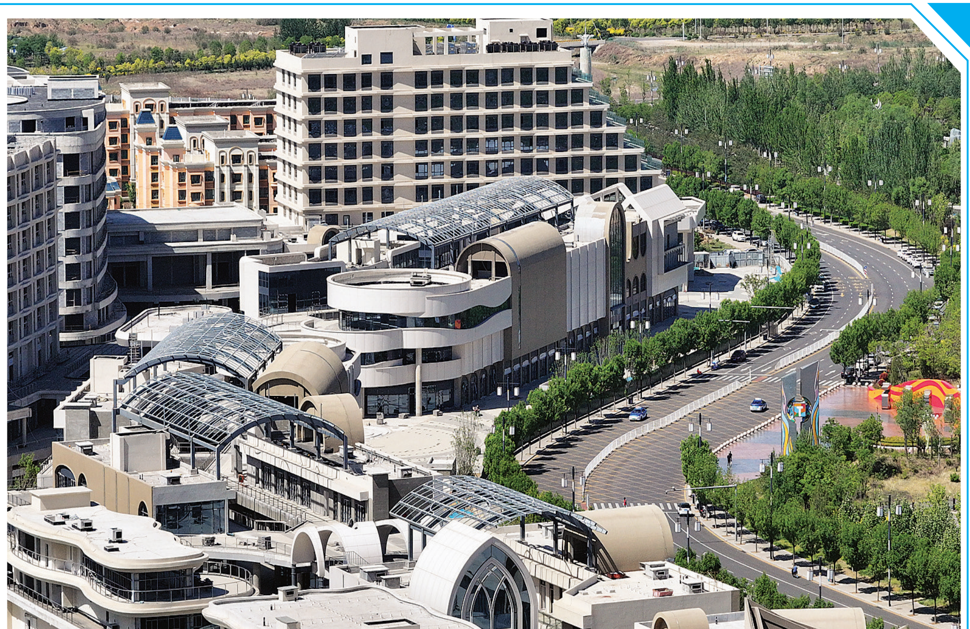
5月10日,山西转型综合改革示范区阳曲工业园区暖泉湾N37项目外立面装饰、窗框玻璃安装、景观绿化等加速推进。 张昊宇 摄
