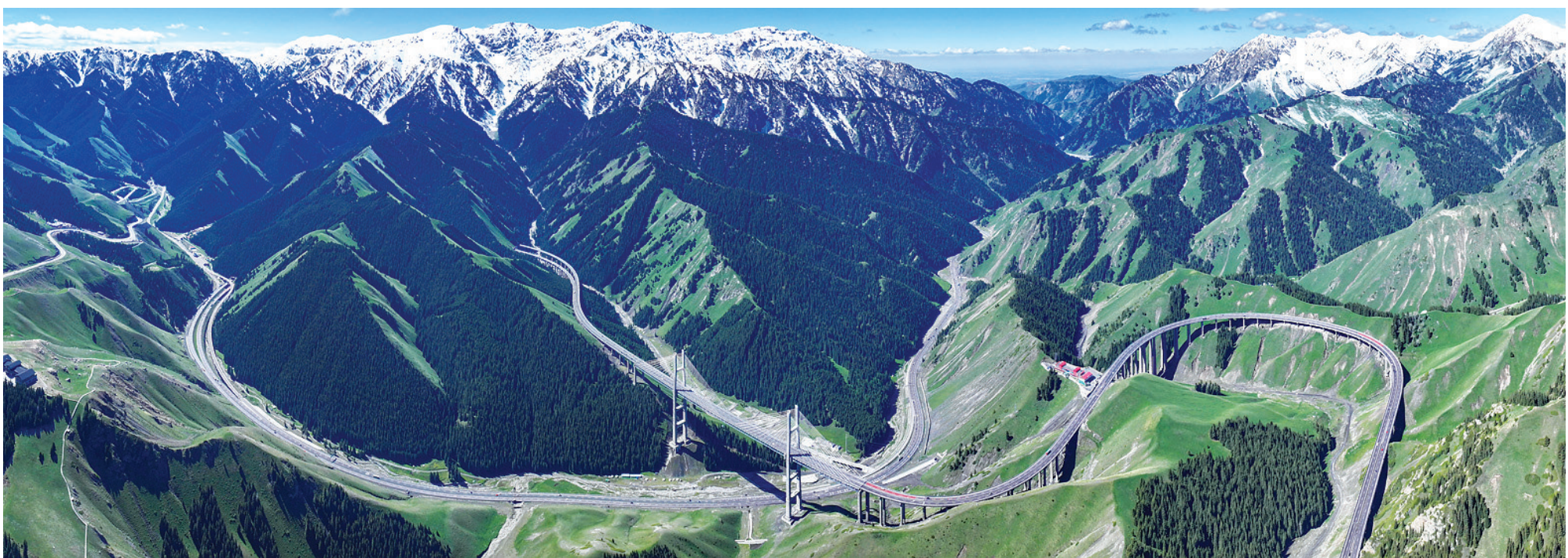
连霍高速公路果子沟段穿越天山山脉(5月13日摄,无人机全景照片)。果子沟位于新疆伊犁霍城县,是伊犁河谷的咽喉要道,被誉为“伊犁第一景”。雨过天晴,果子沟雪峰耸峙,峡谷回环,连霍高速公路果子沟大桥与自然景观融为一体,分外壮美,吸引游人驻足赏景。
