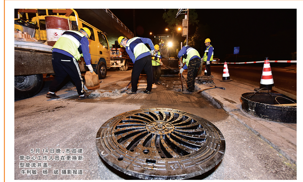
5月14日晚，市政建管中心工作人员在更换新型旋流井盖。牛利敏 杨斌 摄影报道
