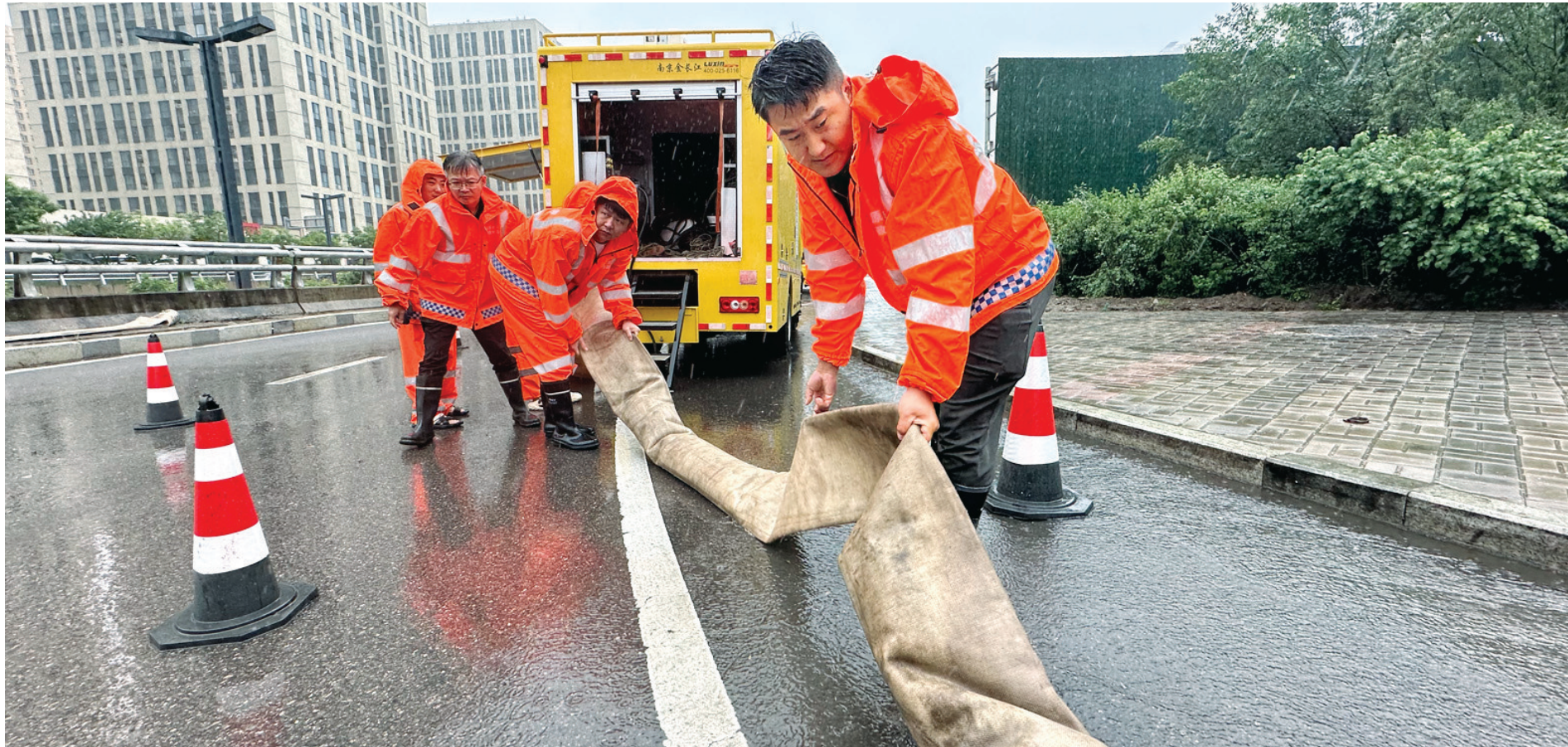
▲ 5月17日,市市政建管中心防汛人员全力开展管线疏通抽排作业,筑牢排水安全防线。 牛利敏 摄
