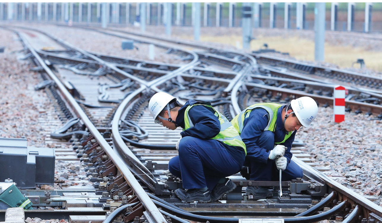
临近汛期,中铁电气化局太原中铁路公司积极应对,加强应急准备,排查潜在隐患,巩固市民出行“安全堤”。图为5月25日,太原地铁2号线贾家寨车辆段露天执行区内,信号检修工冒雨对道岔转辙机检修。王韵非摄
