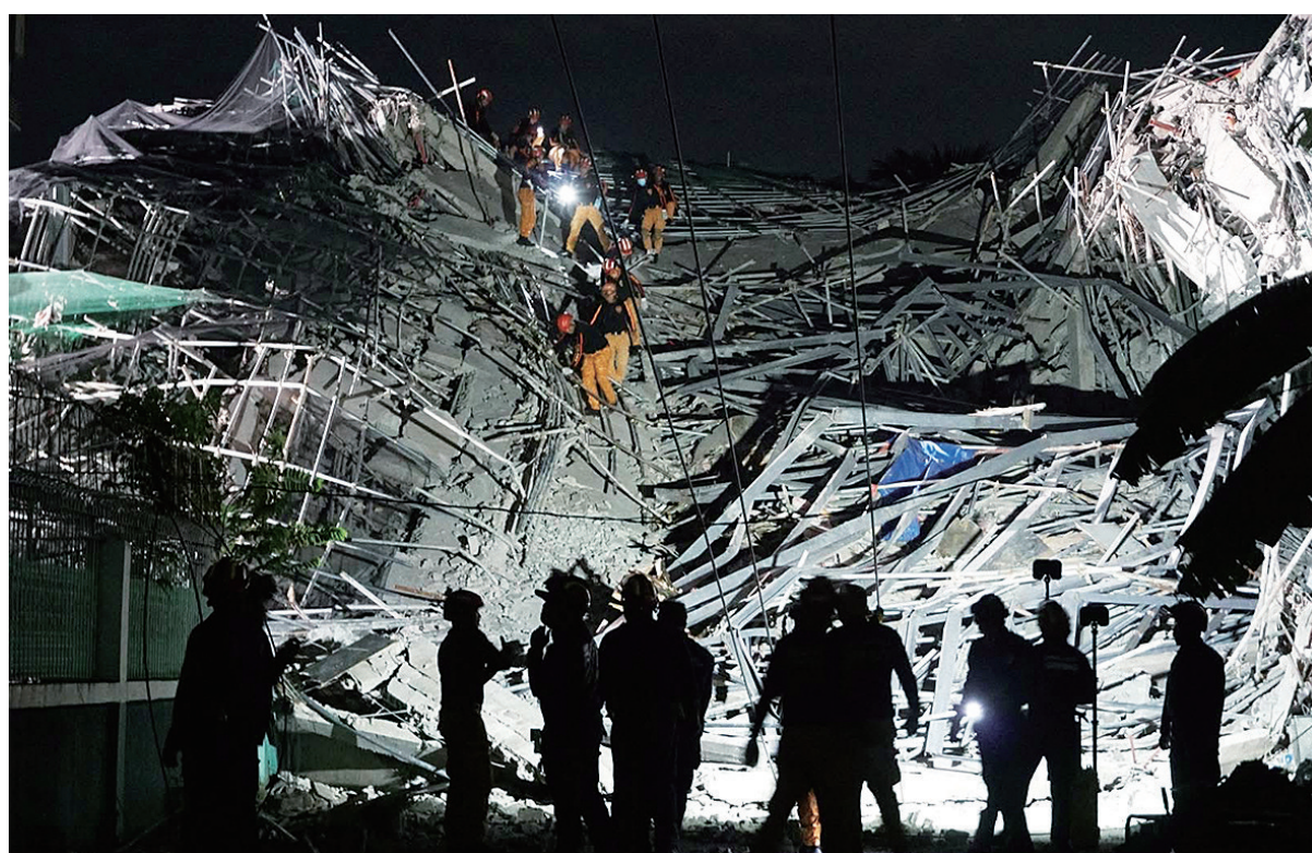
5月24日，救援人员在菲律宾北部邦板牙省安赫莱斯市的楼房坍塌现场工作。据当地媒体5月25日报道，菲律宾北部邦板牙省安赫莱斯市一栋在建楼房24日凌晨发生坍塌，已造成3人死亡，另有18人失踪。新华社发
