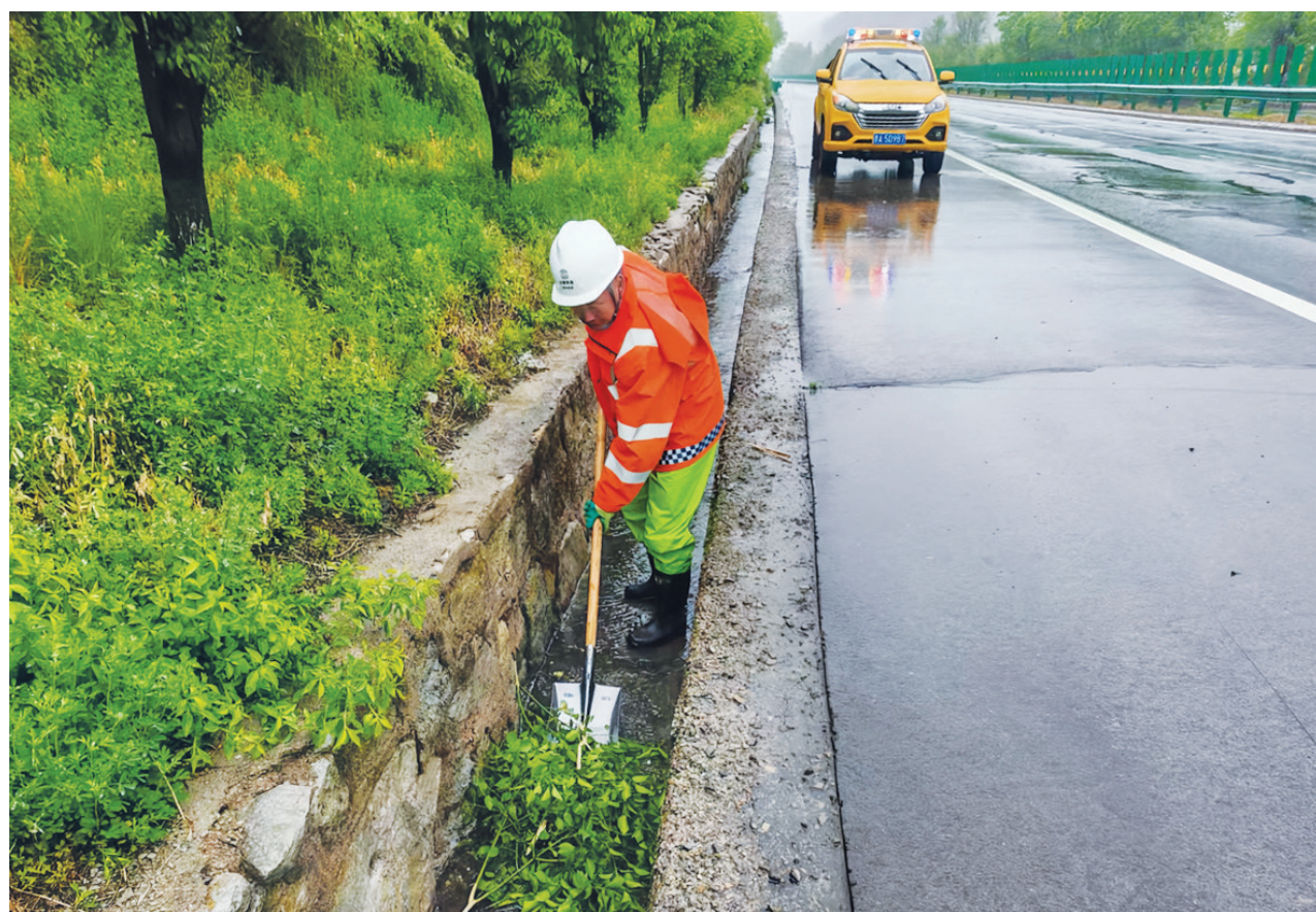
山西路桥集团太佳东公司积极应对降雨天气，组织各基层单位开展汛期安全隐患排查整治，全力保障辖区道路通行安全与运营平稳有序。图为5月25日，阳曲养护工区的工作人员清理排水渠中淤积的杂物。王韵菲 燕昱璇 摄影报道
