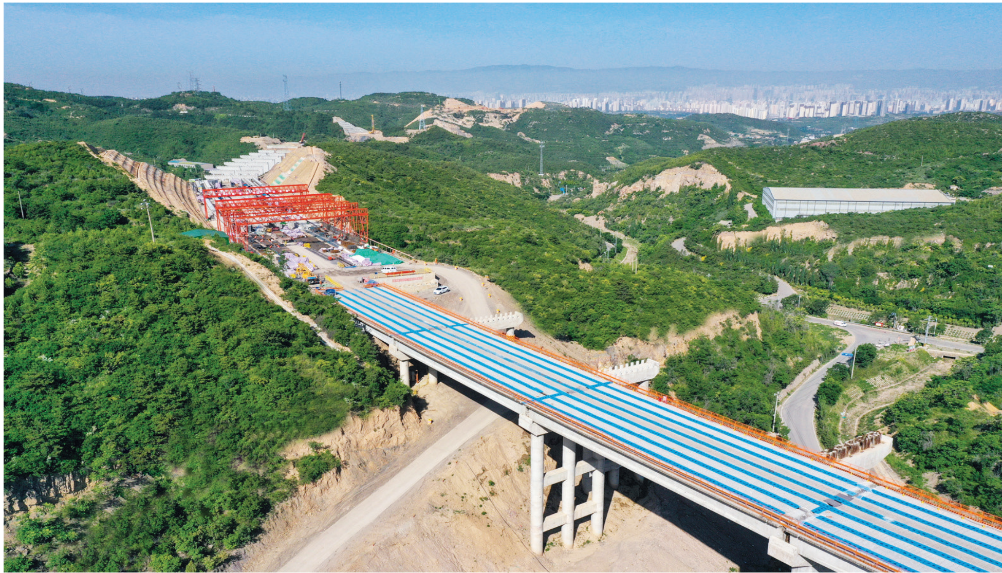
6月2日,青银二广高速公路太原联络线项目外麻地沟处,沟路基、桥梁主体施工加紧推进中,路面铺装及附属设施安装全面展开。青银二广高速公路太原联络线是山西省重点交通工程,也是山西省路网规划核心项目之一,全线采用双向六车道高速公路标准建设,是太原东出阳泉、直达石家庄最便捷的快速通道。牛利敏 摄
