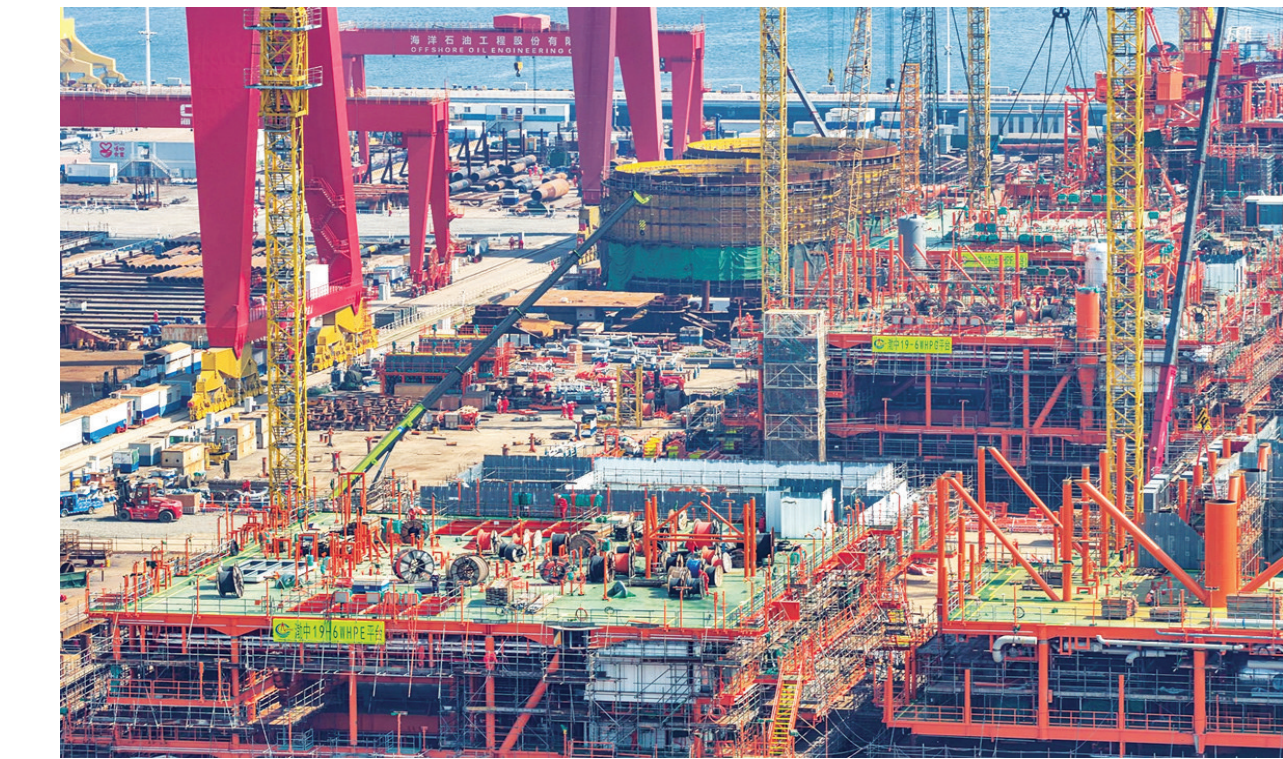
这是6月2日拍摄的渤中19-6气田Ⅱ期开发项目建造现场(无人机照片)。6月2日，渤中19-6气田Ⅱ期开发项目3座平台主体结构在海洋工程天津智能制造基地建造完成，标志着渤海首个千亿方气田Ⅱ期开发项目进入加速建设阶段。新华社发(杜辉辉摄)
