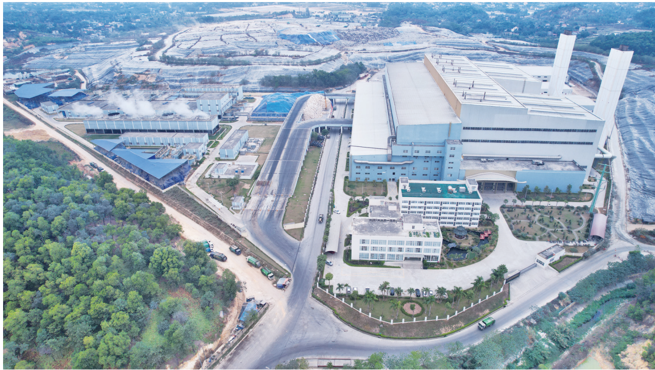
这是2025年4月10日在越南河内拍摄的朔山垃圾焚烧发电厂（航拍照片）。
