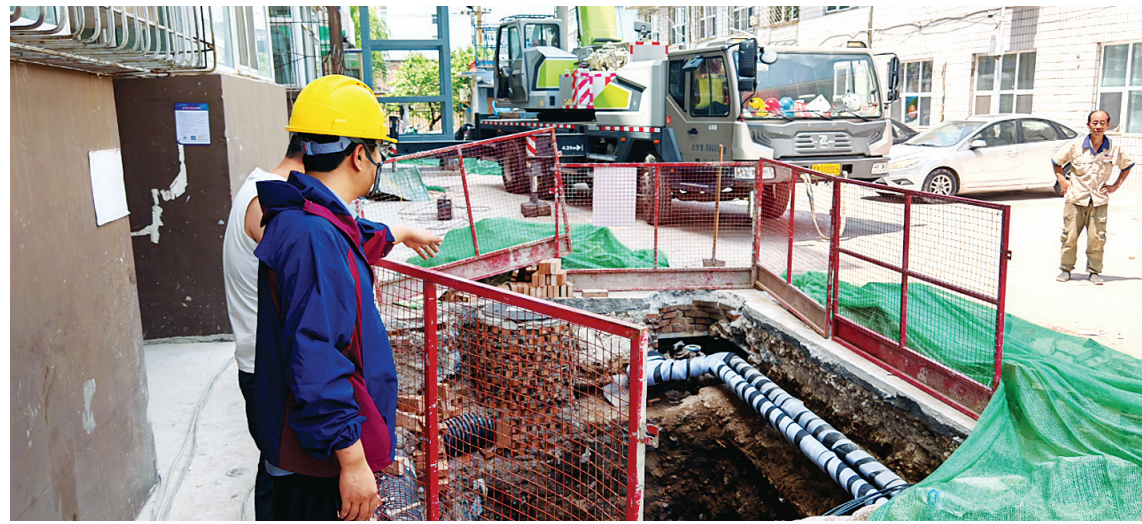
燃料宿舍小区，单元楼前管网改造已完工。
