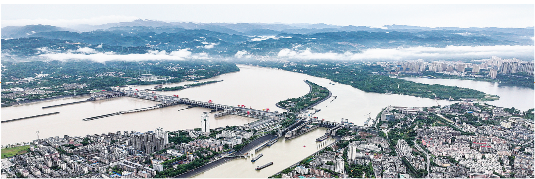
6月8日拍摄的三峡水运新通道工程葛洲坝航运扩能施工现场。新华社记者 肖艺九 摄
