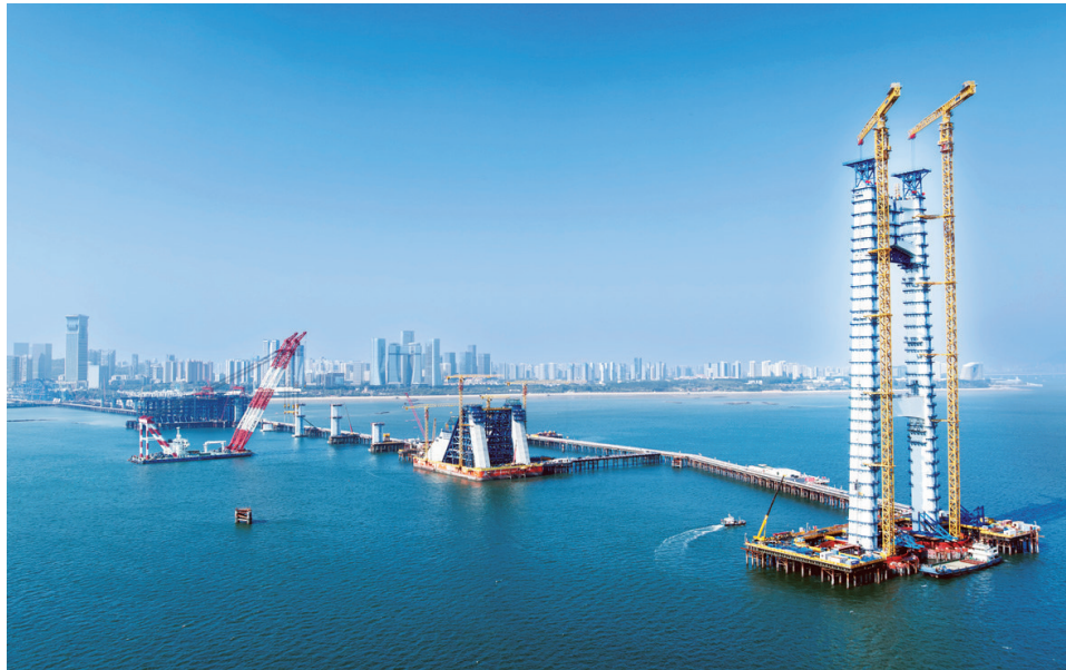
这是建设中的厦金大桥（厦门段）项目A1标段全景（2026年1月9日摄，无人机照片）。新华社记者 魏培全 摄
