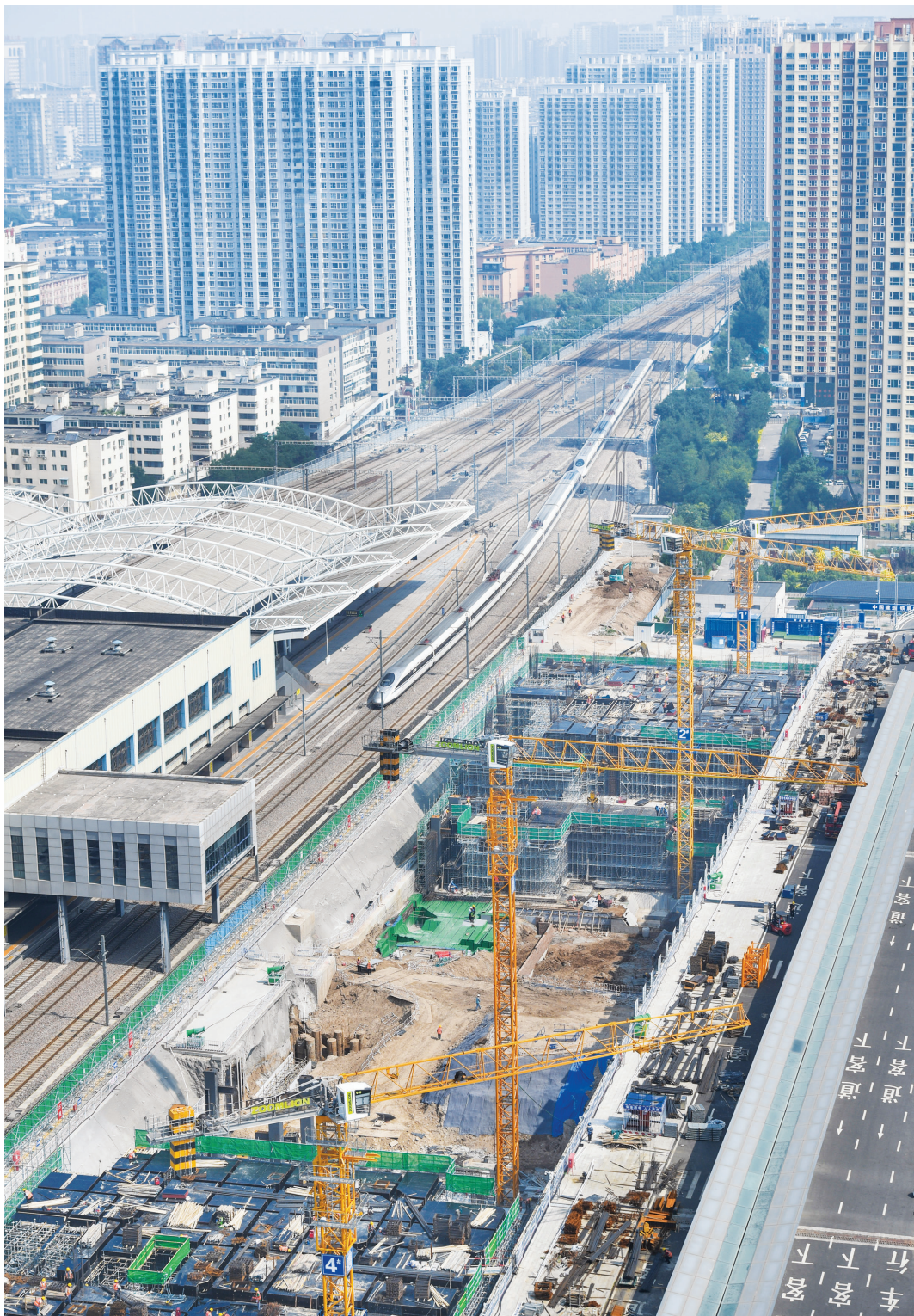
6月15日,太原站新建东进站房工程现场,主体结构建设正有序推进。该工程位于太原站东广场西侧,由站房、换热站、站台雨棚组成。建成后,其将成为集普铁、高铁、地铁、公交于一体的现代化综合枢纽。牛利敏 摄
