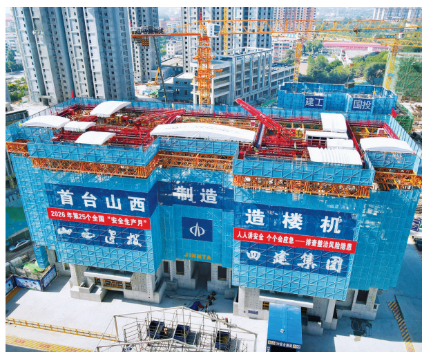
6月18日，首台山西制造造楼机在建筑工地施工。
