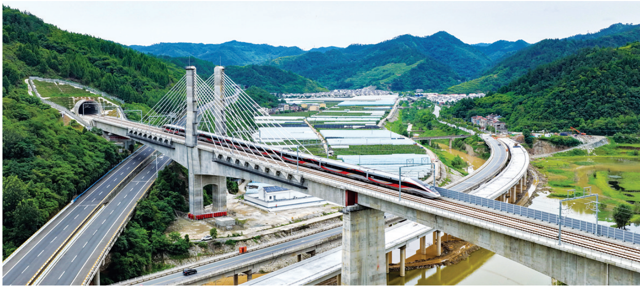
6月30日，列车驶过位于湖北十堰的西十高铁柳家河福银立交大桥（无人机照片）。
