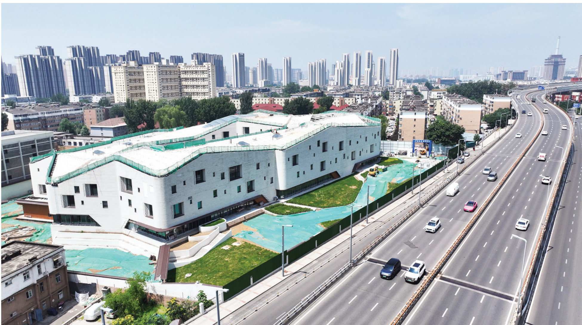
7月4日，康乐幼儿园(五一北路校区)新建项目建筑工地，主体结构已初现雏形。该项目位于杏花岭区洞河路以南、五一北路以东、享堂街以北，建成后将为周边居民提供优质的学前教育资源。 张昊宇 摄
