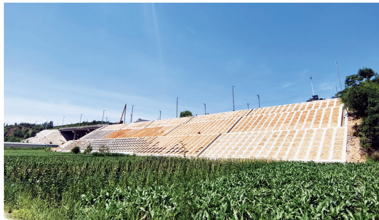
7月3日,阳兴大道高填方段护坡病害专项治理工程已完成各项施工任务。该工程自5月15日开工以来,完成了拱形骨架边坡防护施工、路基加固处置、道路沥青面层修路等,消除了交通安全隐患,提升了边坡安全防护能力。
