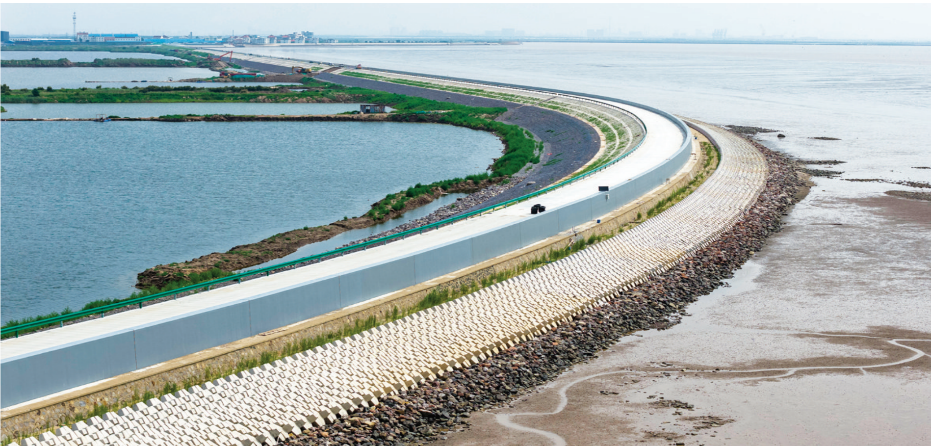
这是7月12日拍摄的天津市滨海新区防潮海堤一期工程（无人机照片）。
