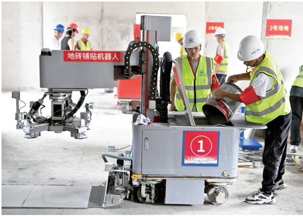
7月3日，2026年江苏省住宅工程人机协同瓷砖铺贴质量控制与效率提升技能竞赛在中铁建工集团南京一处保障房项目工地举行，这是比赛现场。
