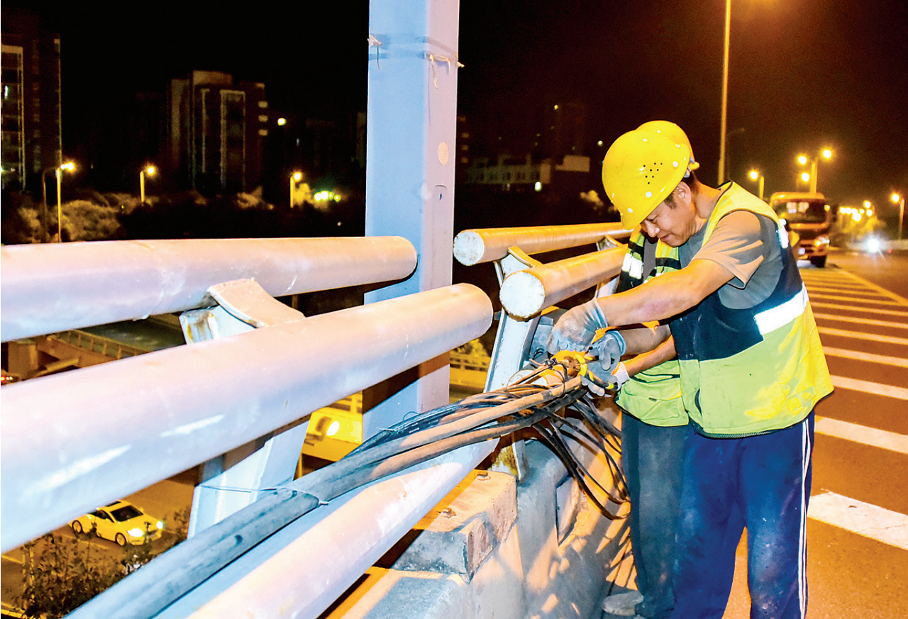
7月14日凌晨，市政桥梁管理所对东中环许坦东街至龙兴街跨线桥沿线22500米废弃线纆展开专项清理。
