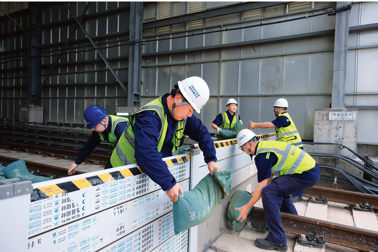
目前,我市进入“七下八上”防汛关键期。7月16日,中铁电气化局太原中铁轨道公司在其运营的原太原地铁2号线贾家寨车辆段露天轨行区开展防汛应急演练,演练通过模拟车场出入段线因暴雨致积水,存在倒灌正线风险,机电各专业开展紧急处置,检验了应急预案与多方协同应急能力。
