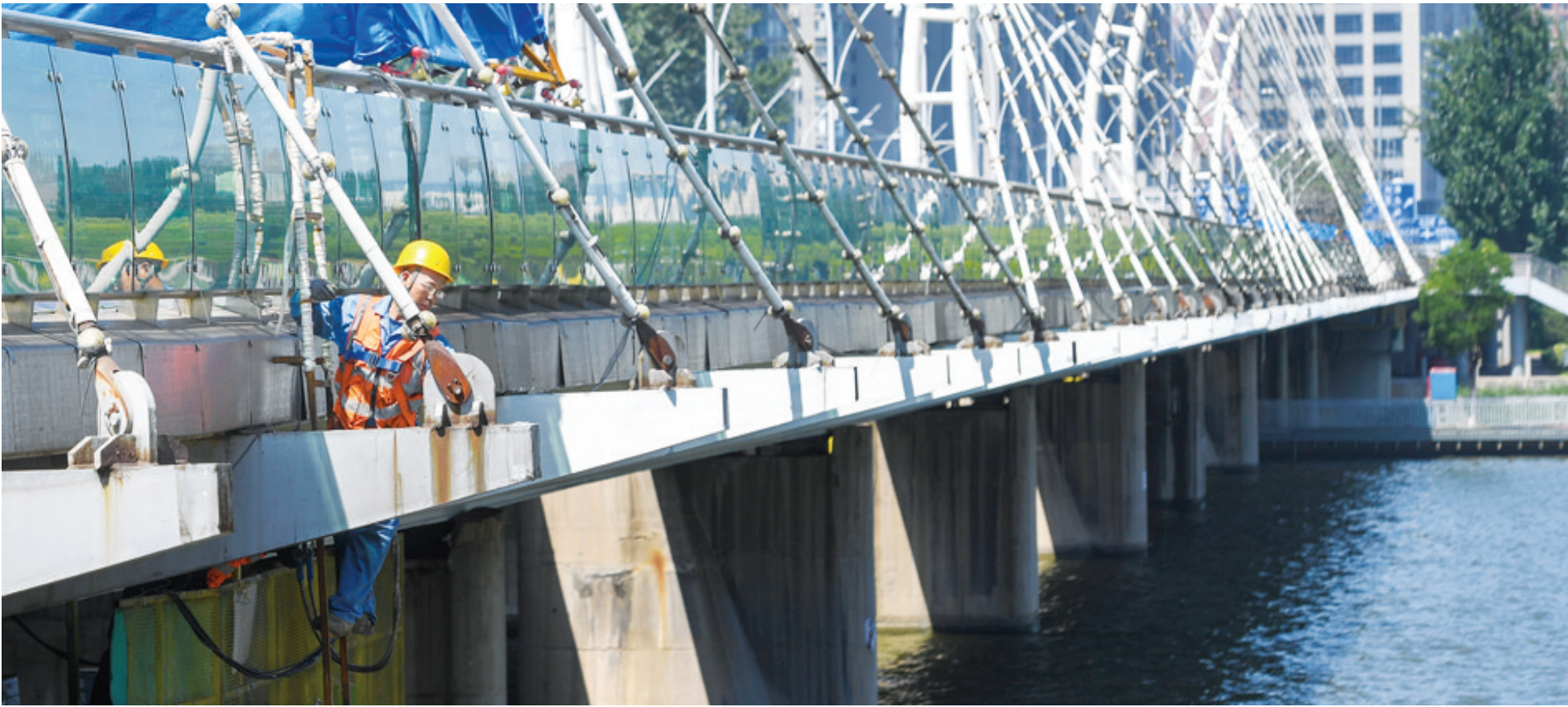
7月17日,南内环桥人行辅道改造工程现场,施工人员进行桥体除锈、打磨及喷涂等作业。目前,该工程正有序推进,人行道防腐木板、伸缩缝全部拆除完毕,新设钢结构地板铺设完成。 牛利敏 摄
