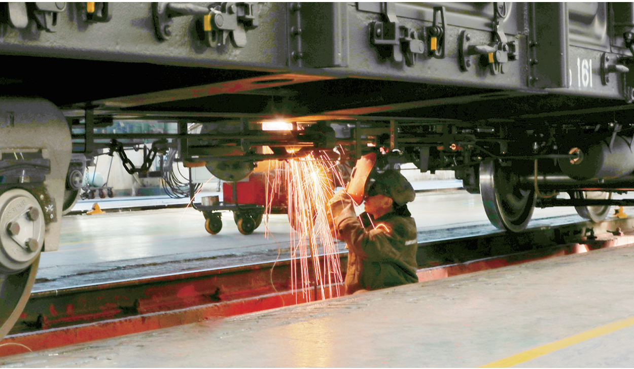
7月19日，中车太原机车车辆有限公司货车钢结构车间内，工人进行制动系统附属件焊接。该公司严把产品质量关与安全生产关，全力保障铁路货车维修任务如期完成。
