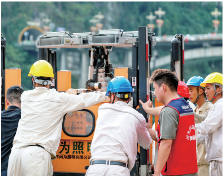
志愿者在协助搬运电力照明设备。
